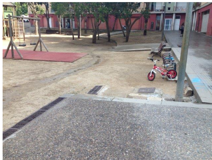
Imatge 13. Vista reixa de drenatge i embornals.
