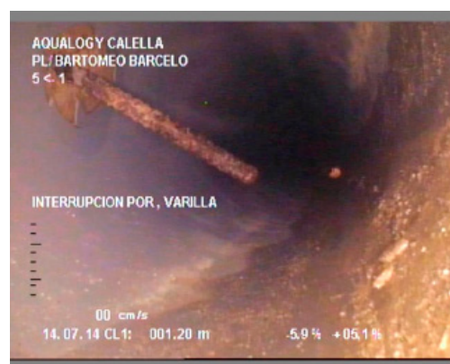
Imatge 3 Trencament puntual per vareta.
