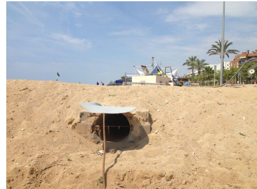
Imatge 2. Desguàs sobreexidor.
