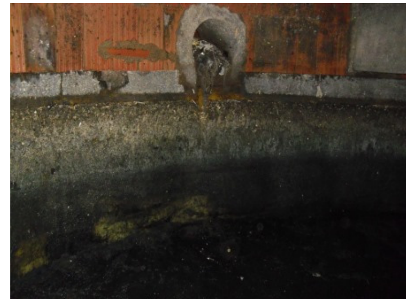
Imatge 178. Canonada desguàs, cambra 3.
