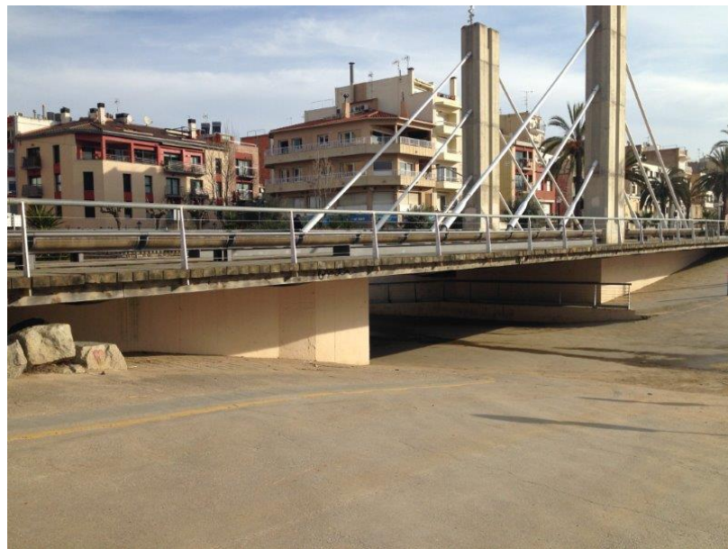
Imatge 4. Pont sobre riera Capaspre.
