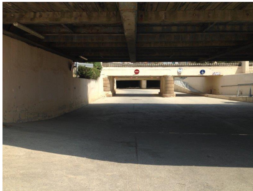
Imatge 5. Vista sota pont riera Capaspre.
