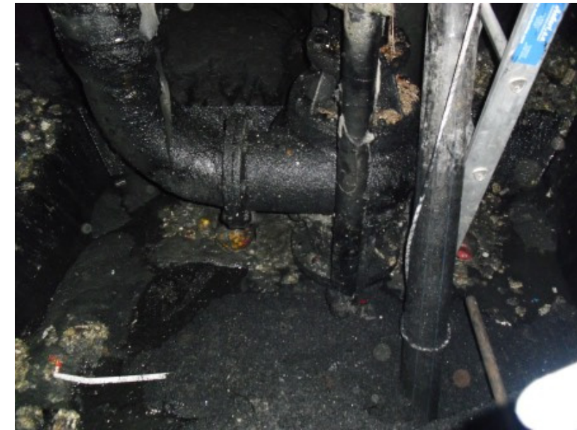
Imatge 14. Sistema aspiració/impulsió i tubs de neteja.
