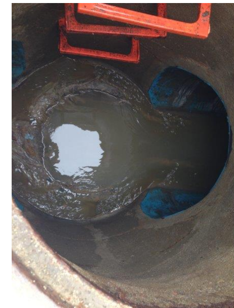
Imatge 7. Vista pou sifònic 0770, a la plaça de Sant Elm.
