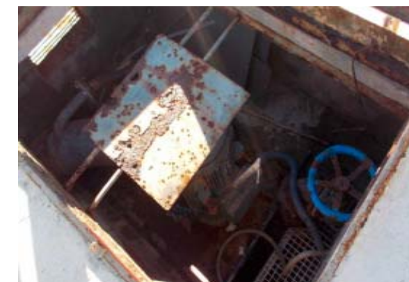
Imatge 6 Accés a la EBAR.
