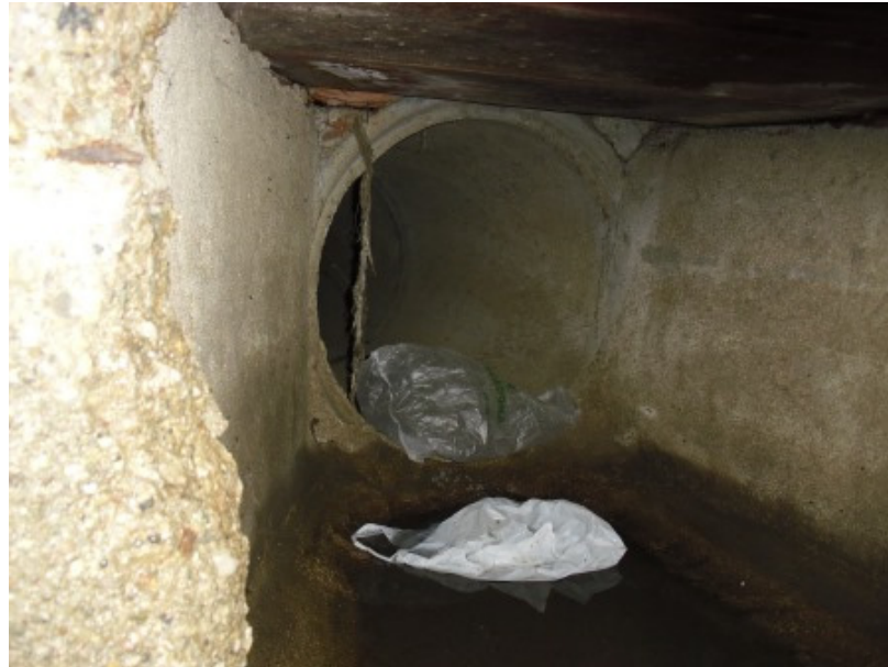
Imatge 12. Sobreixidor, cambra 2.
