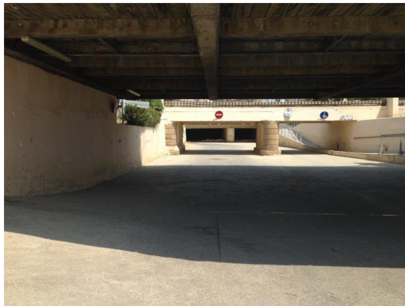
Imatge 5. Vista sota pont riera Capaspre.
