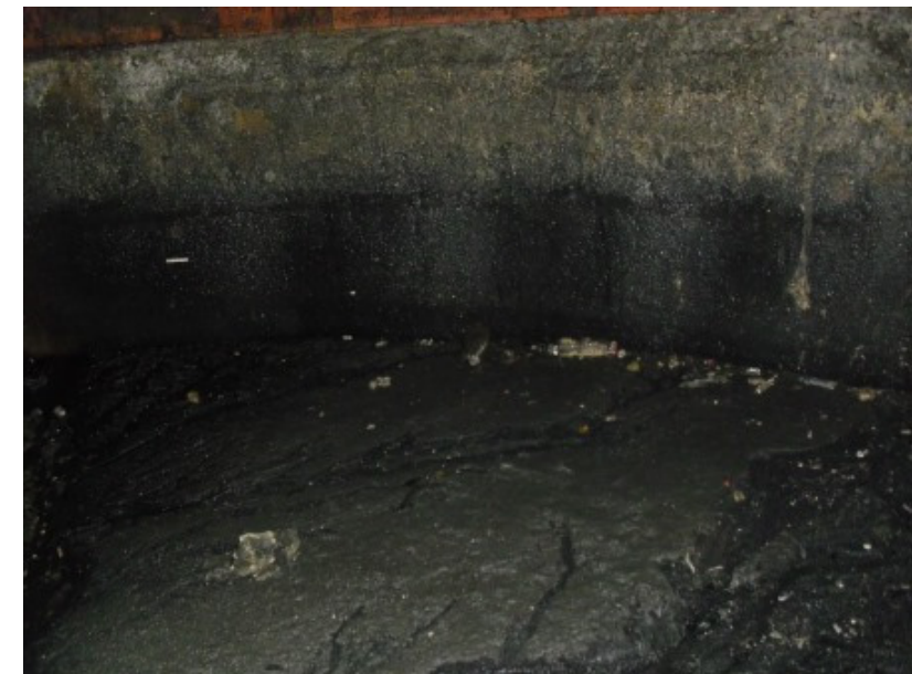
Imatge 15. Vista interior cambra 3.
