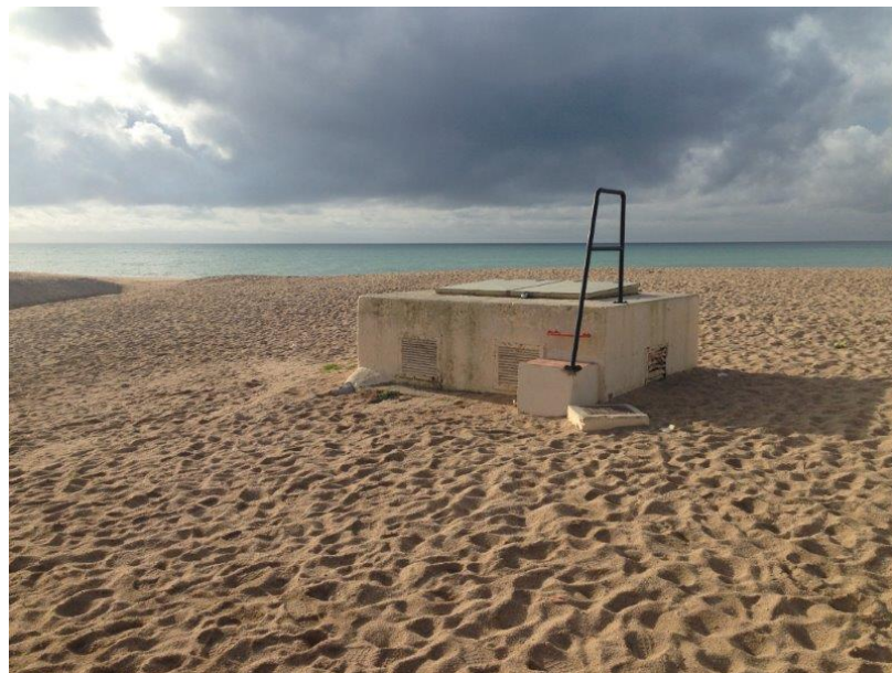
Imatge 1. Vista exterior EBAR.
